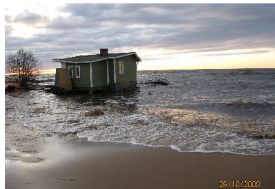
Vesi nousussa Sotalisussa, kuvattu 26.10.2008
